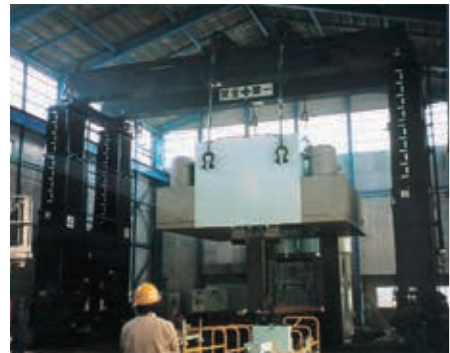
プレス機搬入・据付作業 (TB-2000)
