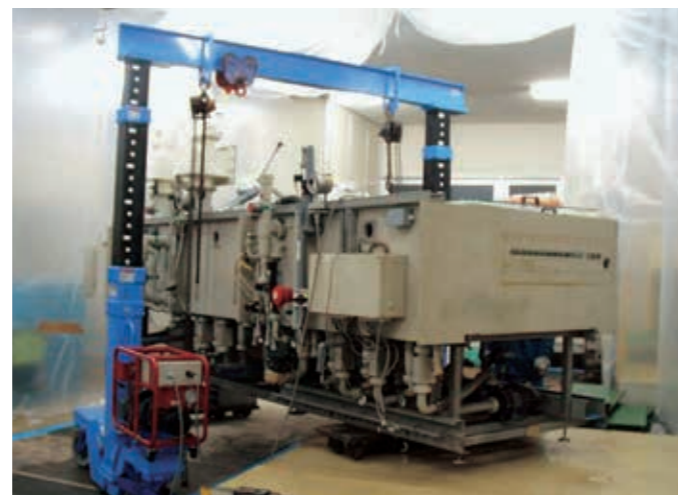
装置組立・据付作業 (TB-30)
