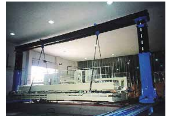
倉庫内 揚重作業 (TB-300)
