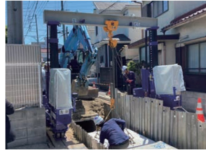
ボックスカルバート設置作業 (TB-50)
