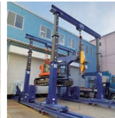
建屋外 装置搬入作業 (TB-100 × 2)
