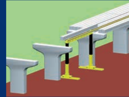
② PC桁の架設作業
