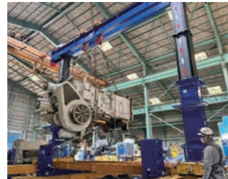
工場内 機器輸送作業 (TB-300)
