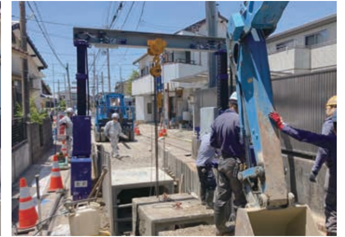
ボックスカルバート設置作業 (TB-50)
