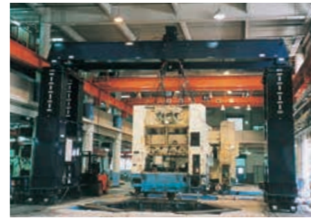
プレス機搬入・据付作業 (TB-1000)
