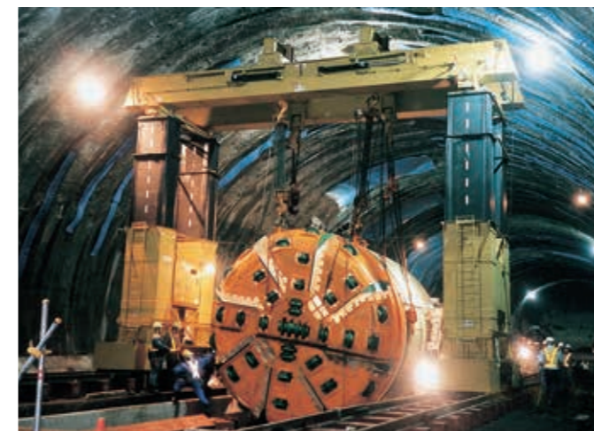
トンネル内工事現場 TBM組立作業 (TB-1000)
