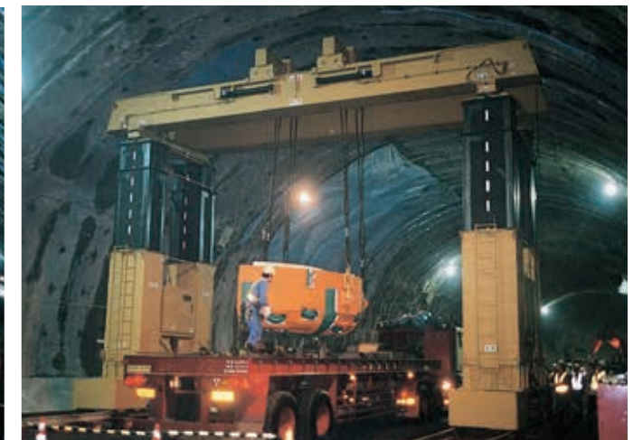
トンネル内工事現場 TBM組立作業 (TB-1000)
