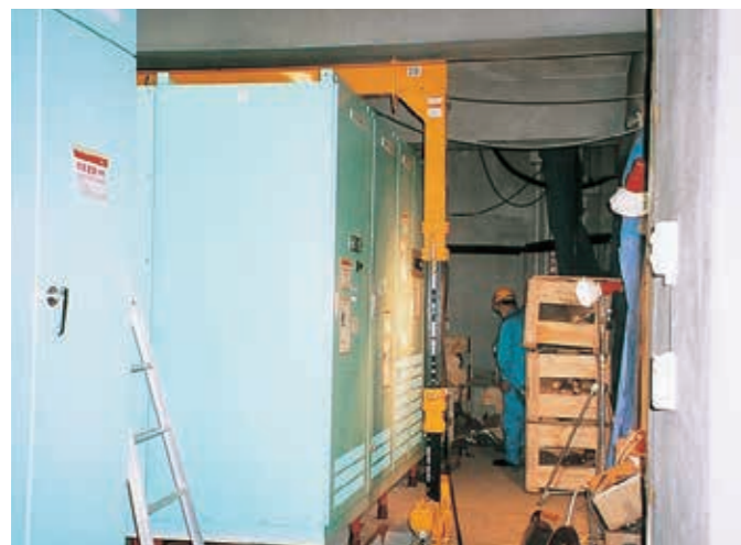
制御盤設置作業 (TB-20)
