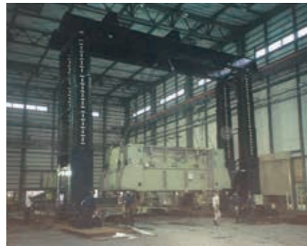
プレス機搬入・据付作業 (TB-1000)
